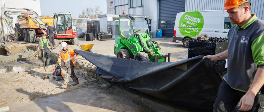
Infiltratiekratten onder bestrating
